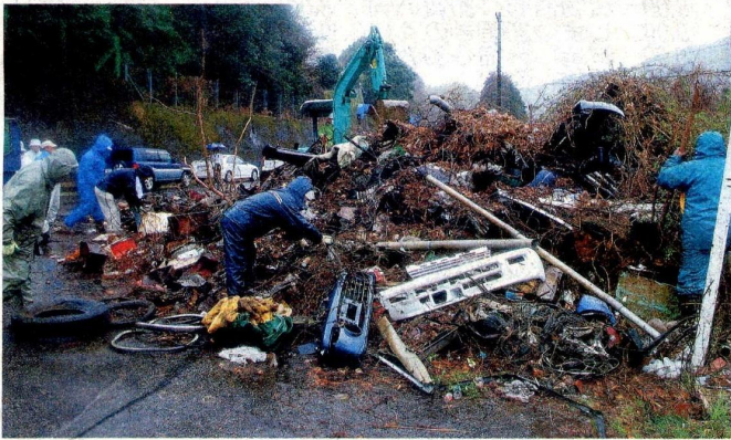
山積みされた自動車の廃材や廃家電を撤去する 参加者—阿南市福井町の鉦打橋周辺
