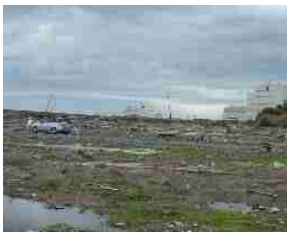
南相馬市の津波による火力発電所周辺の様子
